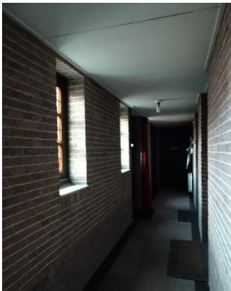
Afb. 91. Toegang naar sacristie, met buitendeur
