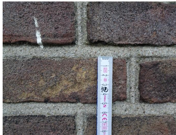
Afb. 24. Lagenmaat, hoogte van een baksteen + 1 voeg is 6,25 cm
