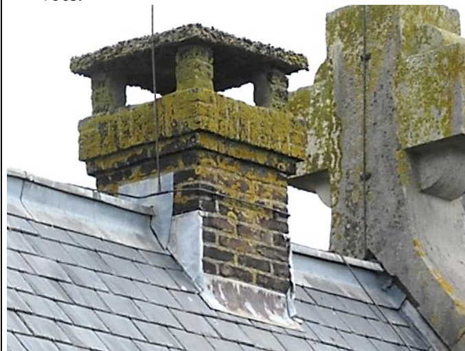
aanzicht schoorsteen (foto 2022)
